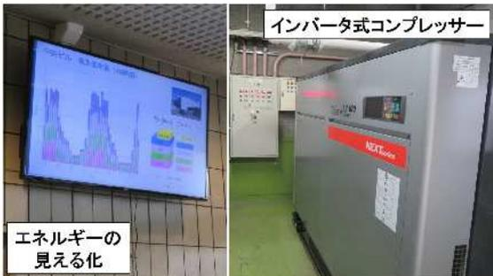
航空機の整備拠点である厚木工場において、コンプレッサー、照明などの高効率化のほか、配電電圧の昇圧化(3kVから6kV)による電力損失の低減を積極的に進めている。また、エネルギー使用割合の大きい塗装工程の運用改善や、工場内のエネルギー見える化による社員の意識向上の促進など、運用対策にも取り組んでいる。平成29年度は、これらの取組により基準年度(平成26年度)に対して約29%とCO<sub>2</sub>排出量の大幅な削減を実現した。
