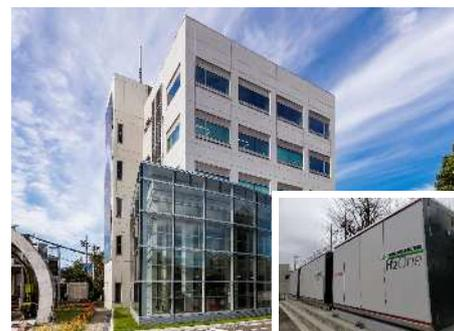
竣工から25年経過した技術研究所の管理研究棟について、外壁の外断熱化や高効率機器、BEMSの導入により省エネを図るほか、太陽光発電等の再生可能エネルギー設備を導入するなどにより、建物を使用しながらZEB化を目指して改修した。これにより、「ZEB Ready」としてBELS認証を受けている。また、太陽熱、地中熱、燃料電池の排熱を空調・給湯熱源に利用するほか、自立型水素エネルギー供給システムにより太陽光発電の発電量に応じて水素を製造するなど、先進的な取組を行っている。
